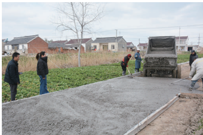
◎ 西渣村联络站代表正在监督水泥路段施工。
